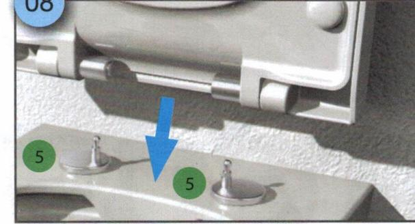
Stecken Sie nun die Abdeckkappen (5) auf die Nylonplatten und schieben anschließend den WC-Sitz wieder auf die Zapfen, sodass er einrastet.
